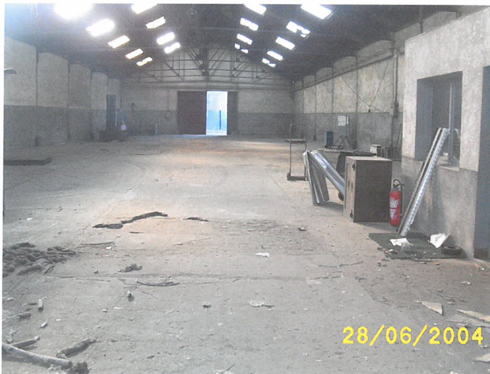
Figure n°8 : Intérieur du bâtiment principal (B1).
